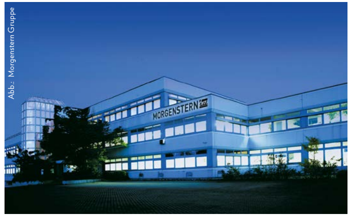
Abb.: Morgenstern Gruppe Die Firmenzentrale in Reutlingen
